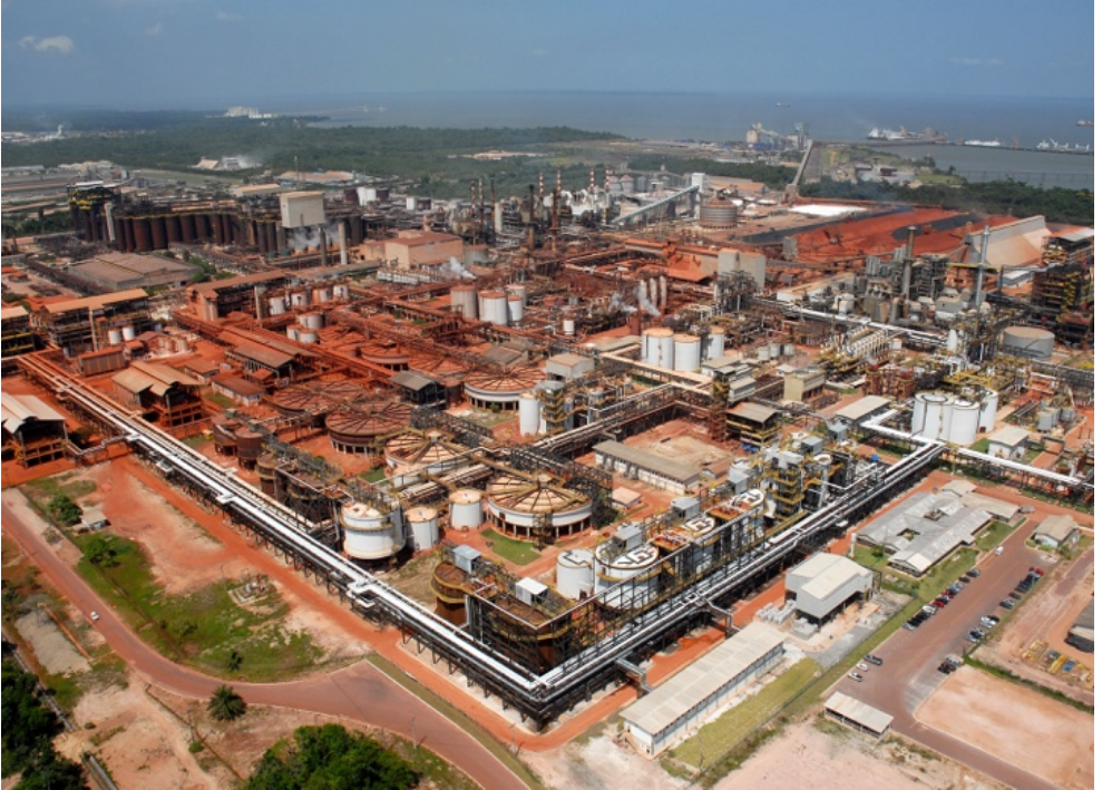
Lo stabilimento Hydro Alunorte a Barcarena, Pará, Brasile
